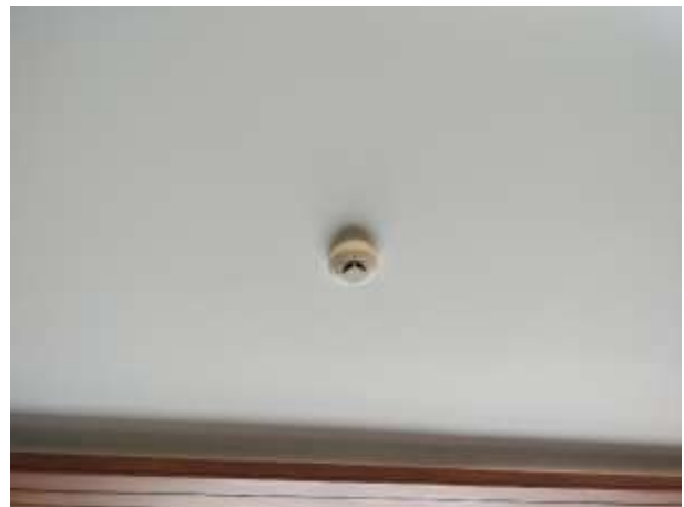
รูปที่ 1-23 เครื่องตรวจจับควัน
