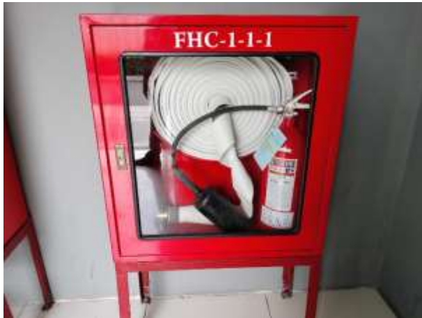
รูปที่ 1-28 ตู้หัวฉีดน้ำดับเพลิงและถังดับเพลิง เคมีภายในอาคาร
